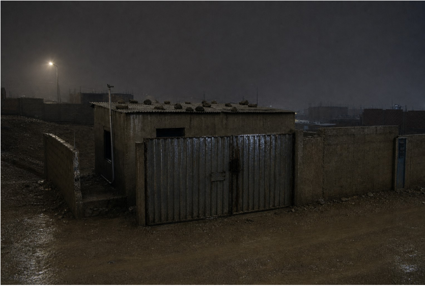
Depósito Norte nach Betriebsschluss. Das Tor ist geschlossen; im Gebäude ist kein Licht sichtbar. Aufnahme: Ana Belén Vargas, 2026.
