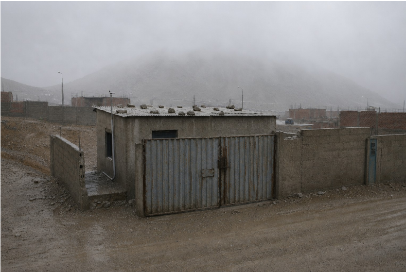
Das Depósito Norte am späten Nachmittag in tiefer Garúa. Derselbe Bau wirkt durch Feuchtigkeit, Bebauung und leicht veränderten Standpunkt anders, ohne seine Form zu wechseln. Aufnahme: Ana Belén Vargas, 2026.
