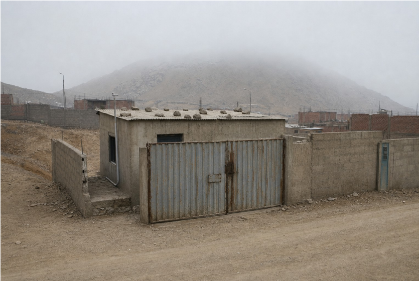
Heutige Gesamtansicht des Depósito Norte, aufgenommen vom ehemaligen camino de servicio. Der Pazifik liegt rechts außerhalb des Bildes und ist in der Garúa nur als Helligkeit zu vermuten. Aufnahme: Ana Belén Vargas, 2026.
