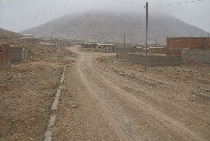
Der frühere camino de servicio mit Reifenspuren und Betonresten, Ende der 1990er-Jahre. Das Depósito liegt in der Bildmitte; Las Palmeras war noch locker bebaut. Privatarchiv José Luis Gamarra.
