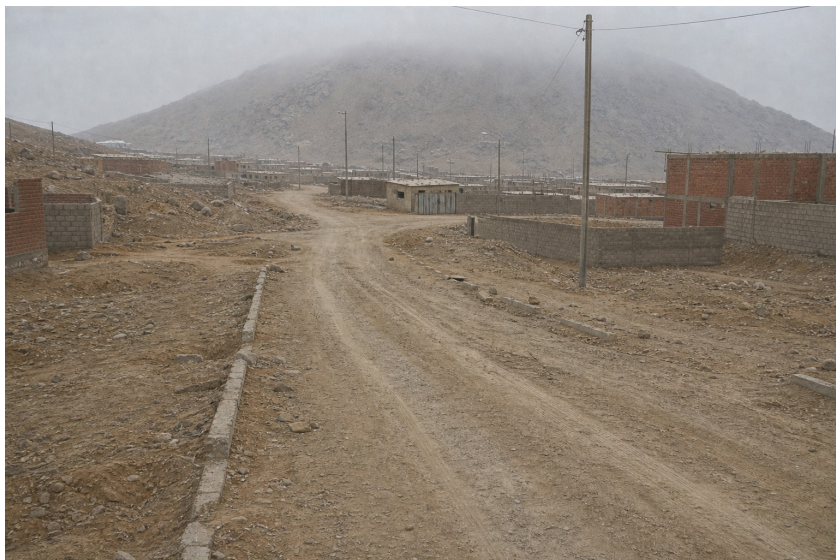
Ex camino de servicio con huellas de neumáticos y restos de hormigón, de finales de los años 1990. El Depósito está en el centro del cuadro; las Palmeras todavía estaba poco desarrollada. Archivo privado José Luis Gamarra.
