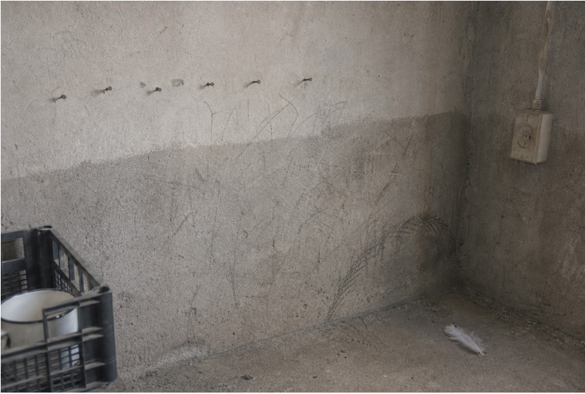
Huellas de uso informal en el interior actual: hilera de clavos, borde de pintura, enchufe viejo, rayones y una taza esmaltada en una caja. Foto: Ana Belén Vargas, 2026.
