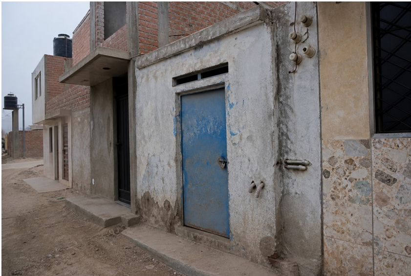
Fig. 5 · La caseta más antigua en la propiedad de Celia Ríos en Las Palmeras. El edificio residencial se amplió más tarde con la sala de hormigón.
