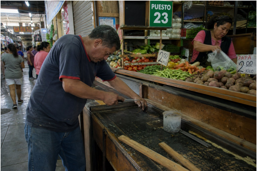
Reparatur eines Verkaufsstandes während des laufenden Betriebs. Der Verkauf wird um die Arbeit herum fortgesetzt.
