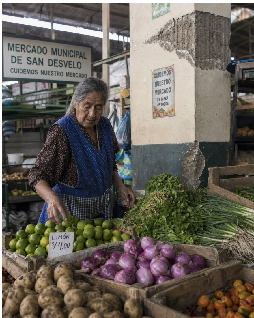
Figura 16. Julia Mendoza en su puesto actual. La columna de concreto dañada sirve como punto de referencia para las fotografías más antiguas.
