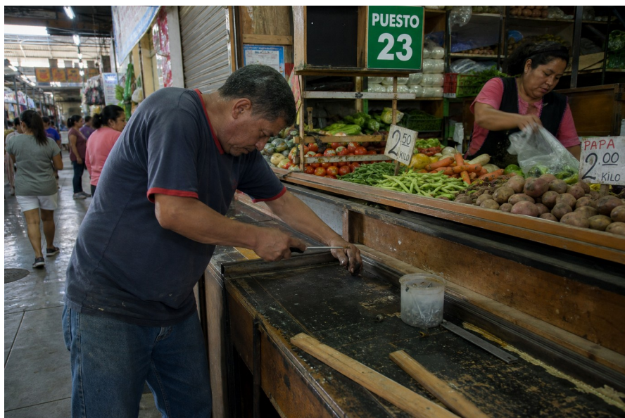
Figura 38. Reparación de un puesto de venta mientras el mercado sigue funcionando. La venta continúa alrededor de los trabajos.
