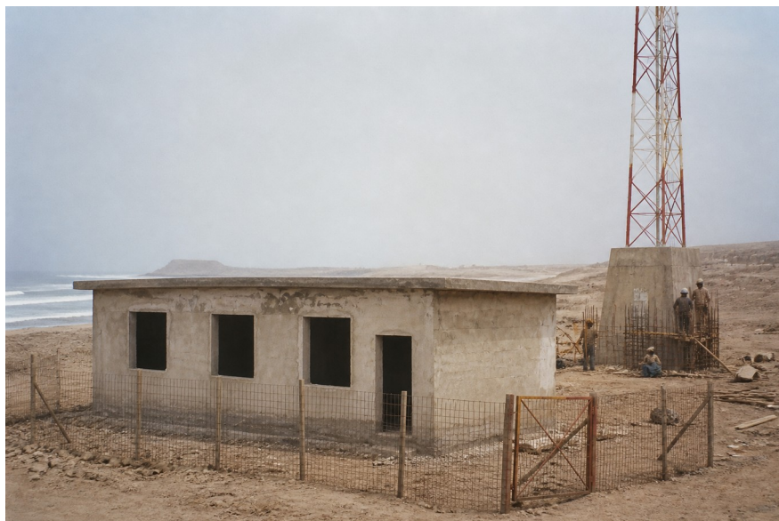
Sendergebäude während der Fertigstellung, vermutlich 1987. Der genaue Aufnahmetag ist nicht überliefert.
