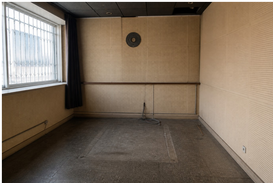
Ehemaliger Studierraum von Radio Desvelo, 2026. Die Standspur des Pults ist erkennbar.
