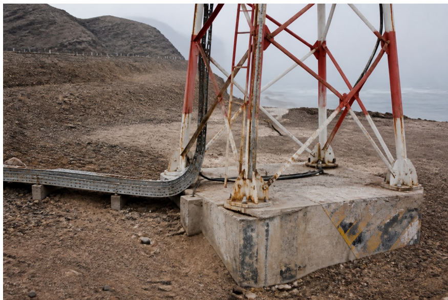
Cimentación del mástil y alimentación de cables. Fotografía: Ana Belén Vargas, 2026.
