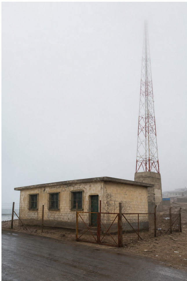
Radio Desvelo al norte de El Faro. Las emisiones regulares terminaron en 2004; el edificio y el mástil siguen en pie en 2026.
