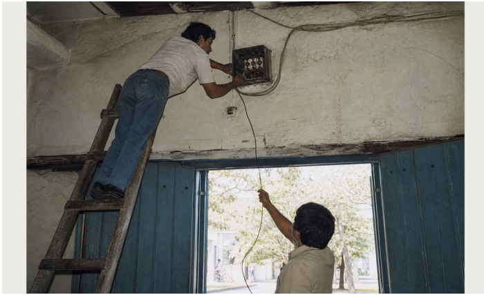
Wartung der elektrischen Anlage vor einer Veranstaltung. Fotografische Rekonstruktion nach Bildplan.
