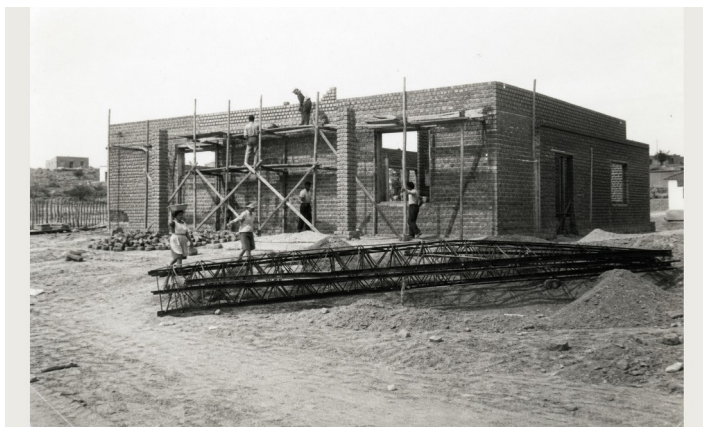
Trabajos de construcción en el posterior Salón Mar Azul, presumiblemente 1968. Fotógrafo desconocido. Reconstrucción fotográfica conforme al plan de imágenes.
